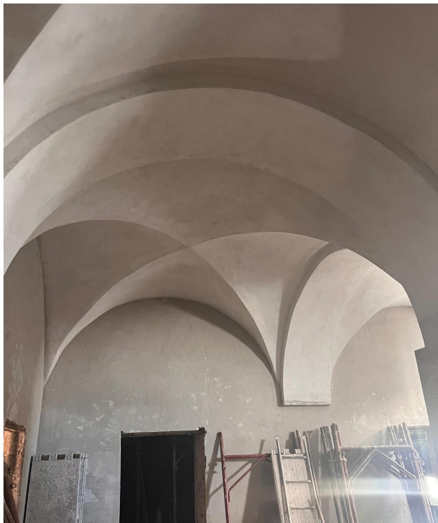
LE VOLTE DEL SOTTOPIANO: PRIMA E DOPO IL CONSOLIDAMENTO
